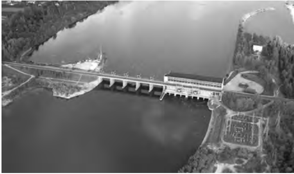
Rys. 9. Zapora i elektrownia wodna na Narwi w Dębem, moc zainstalowana elektrowni wynosi 20 MW, wysokość spiętrzenia wody 5,5 m [3]
