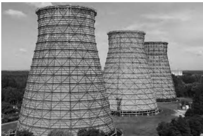
Rys. 5. Chłodnie kominowe elektrowni Halemba
