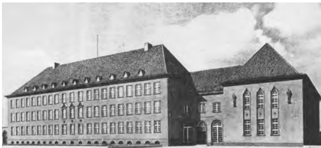
Rys.2. Zabytkowy gmach Wydziału Elektrycznego, lata 50.
