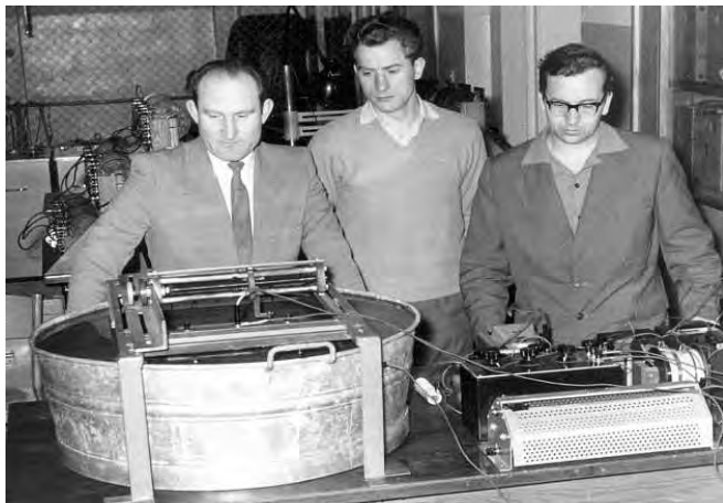
Rys. 5. Badania modelowe uziemień na stanowisku pomiarowym z wanną elektrolityczną, w środku późniejszy członek zespołu katedry Andrzej Wiśniewski
