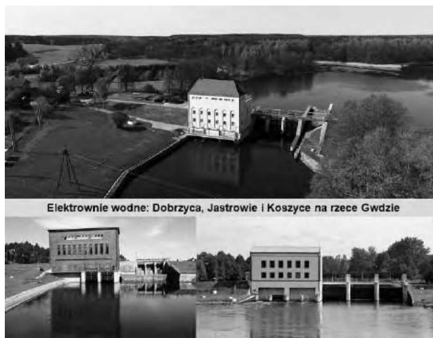
Rys.5 Elektrownie wodne na Gwdzie [3]
