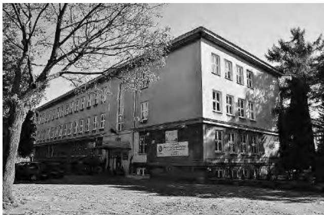
Rys.6. Budynek Szkoły przy ul. Długiej 4a (obecnie ul. Długa 6) oddany do użytku w 1958 r.
