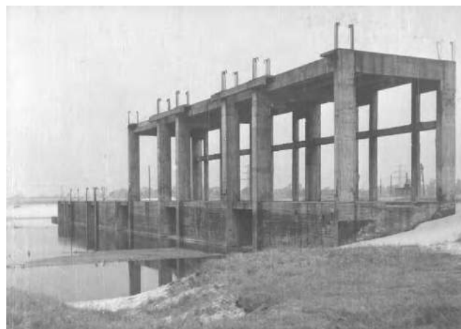
Rys. 1. Poniemiecka galeria w elektrowni
