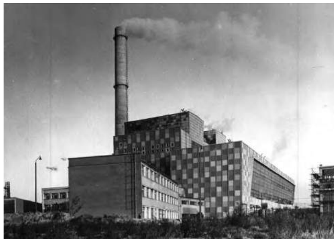
Rys. 2. Budynek administracyjny i główny elektrowni
