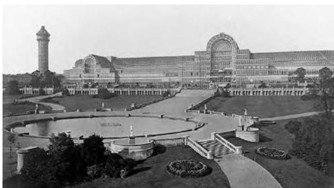
Rys. 8. Pałac Kryształowy w Londynie, w którym firma Gülchera zainstalowała stałe oświetlenie elektryczne jego systemu, zdjęcie z 1854 r. (domena publiczna)
