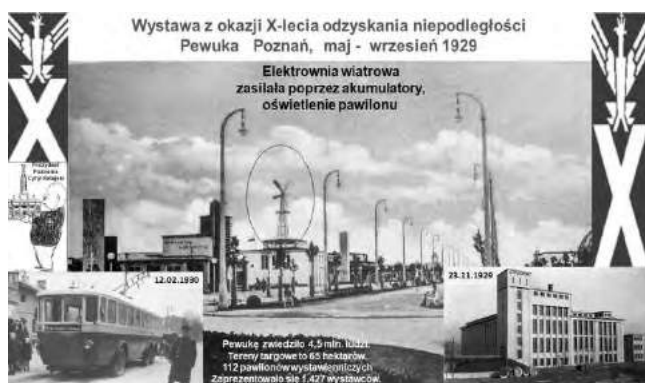
Rys. 4. PEWUKA z widoczną elektrownią wiatrową
